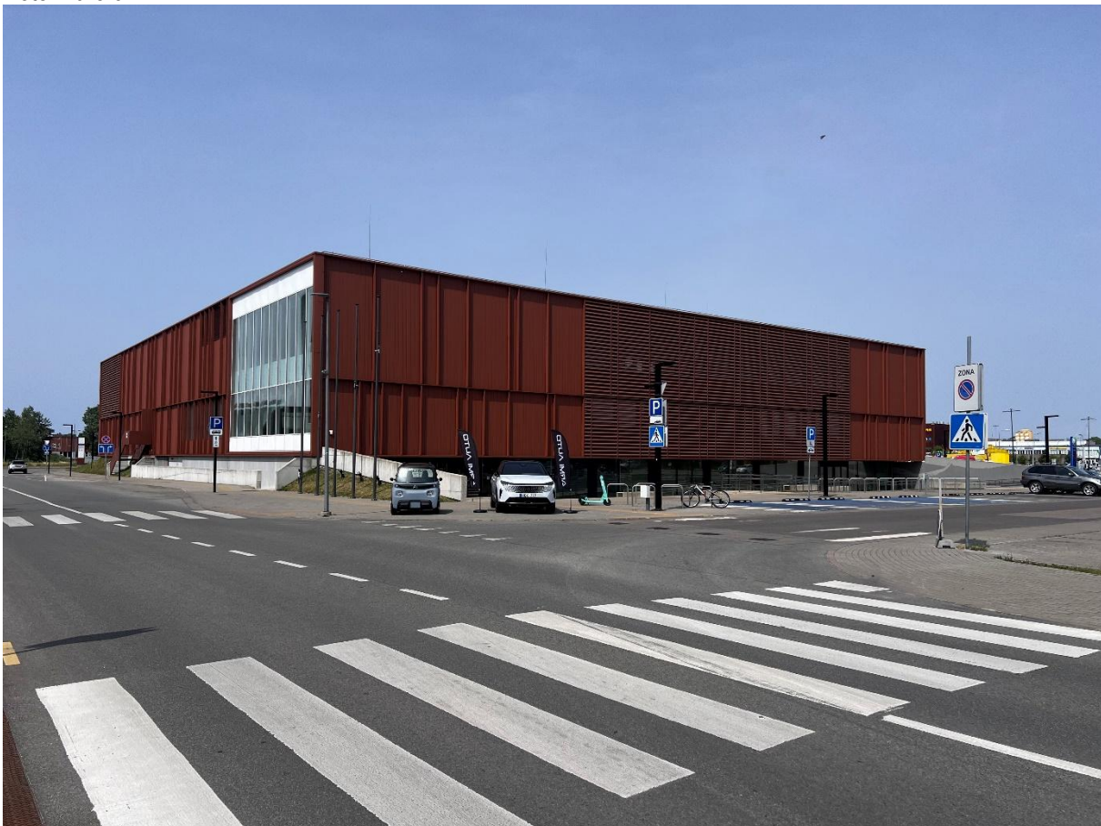
Plavecký bazén Klaipėda
